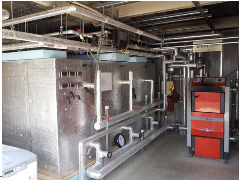
蓄熱タンク、薪ボイラー
