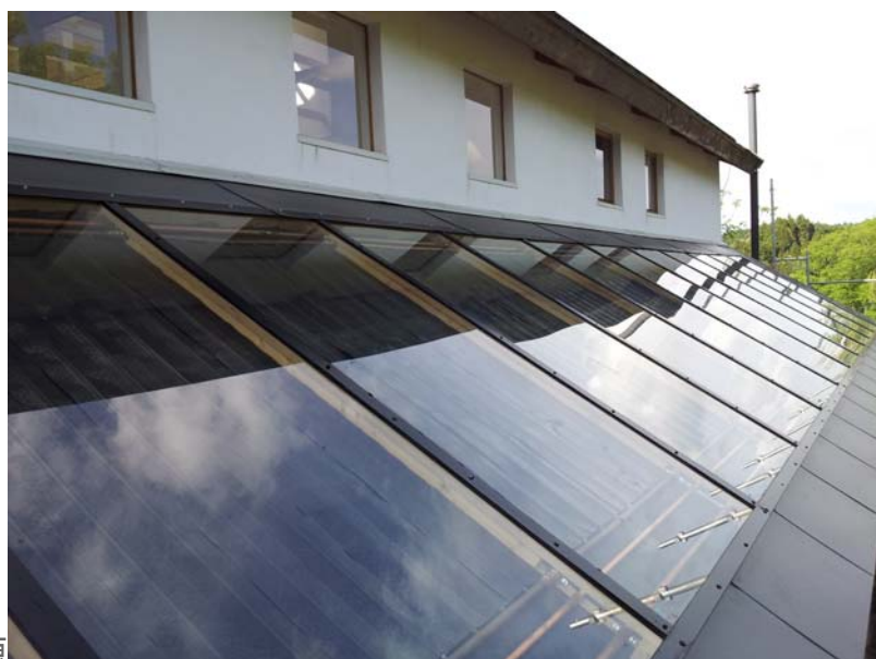
全館床暖房の給湯用熱源を 灯油から自然エネルギーへの改修。
